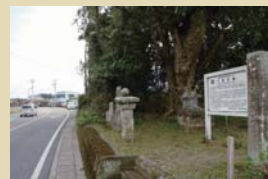
▲墳丘土が流失し天井石が露出。
